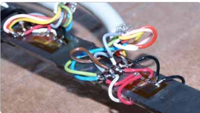
Obr. 2 Inštalácia odporových snímačov povrchovej deformácie s kabelážou
