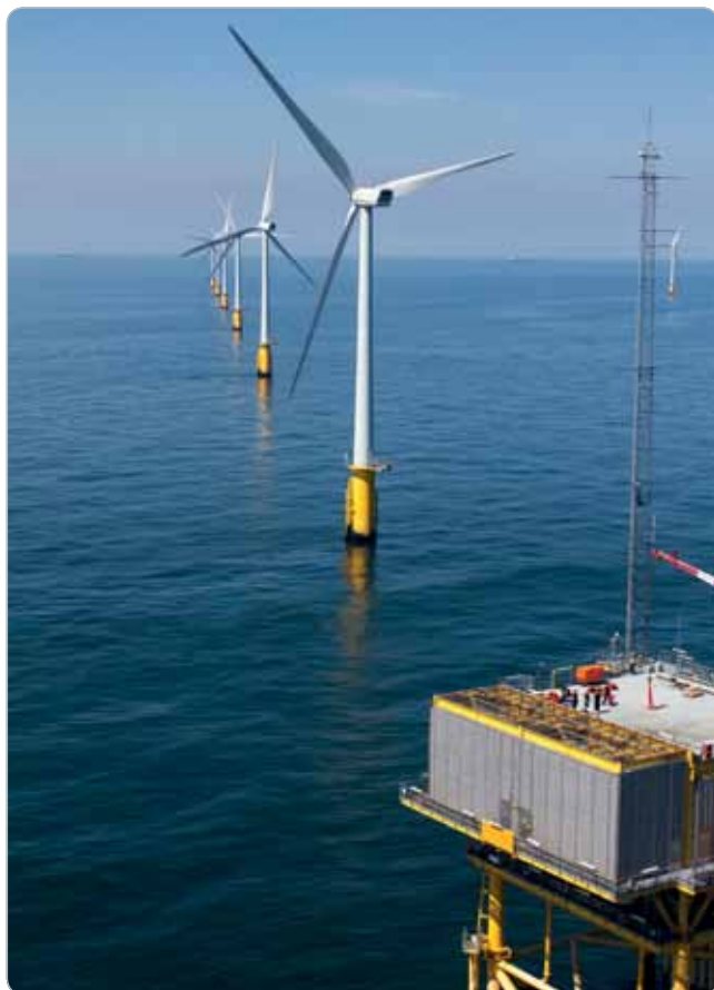
Obr. 7 Systém VDAU-6000 je úspešne prevádzkovaný na viac ako 5 000 veterných elektrárnach.
