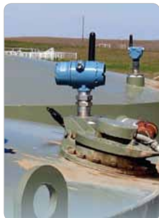
Obr. 2 Bezdrôtové GWR vysielateľ sú vhodné na spojitú meranie výšky hladiny v skladových zásobníkoch.
